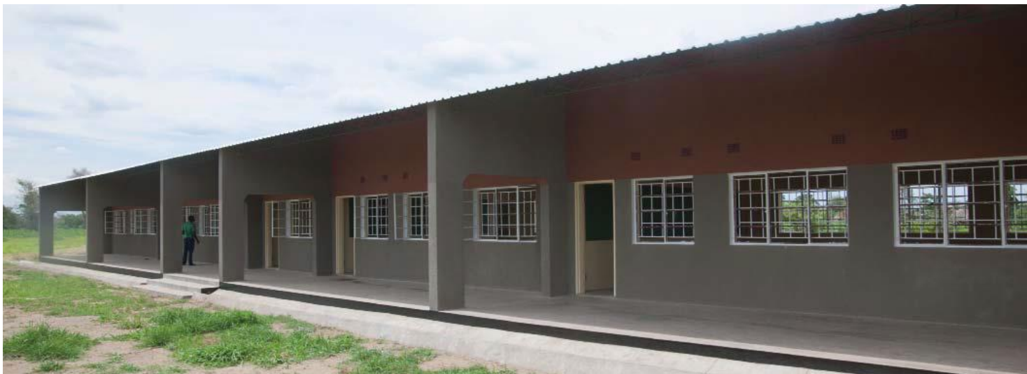
Block mit vier Klassenzimmern
