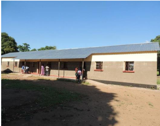
Kakumbi School: von Schulprojekte Sambia renovierter Schulhausblock mit zwei Klassenzimmern. Das Haus wurde von einem Sturm im Dezember 2014 schwer beschädigt und konnte dank unserer sofortigen Hilfe bis April 2015 wieder Instand gestellt werden.
