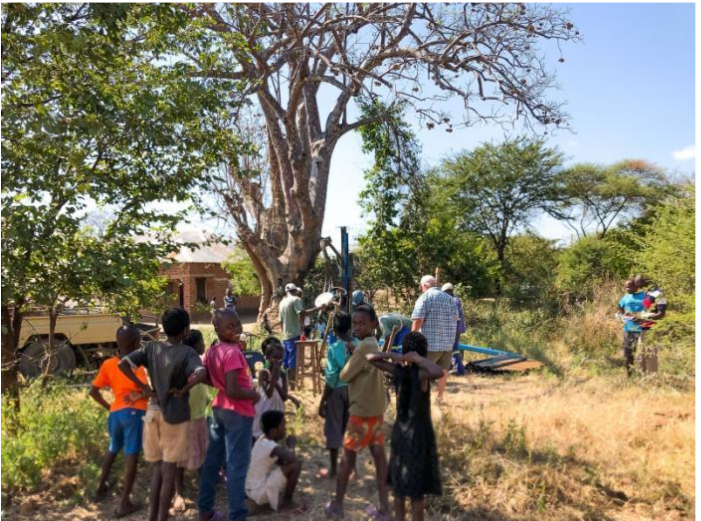
Makolekole Drilling im Nymanunga Village.
