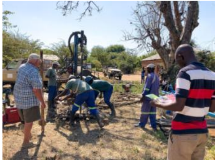
Der neue Brunnen wird gebohrt
