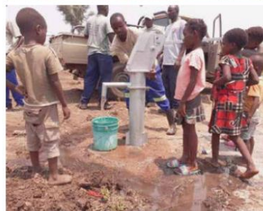
Junge Madimba-Bewohner beobachten, wie das erste Wasser gepumpt und das brandneue Dorfbohrloch fertiggestellt wird.
